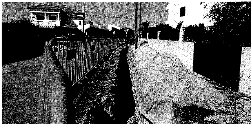
Figura - Vala de instalação de coletor – Rua do Cemitério, Sarilhos Grandes
