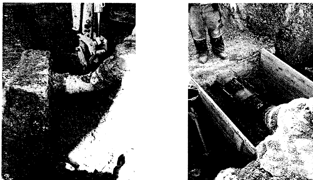
Figura – Abertura de vala para identificação de avaria numa adutora e sua reparação
