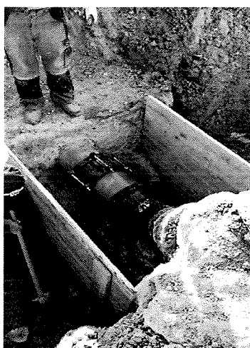
Reparação de rutura em adutora
