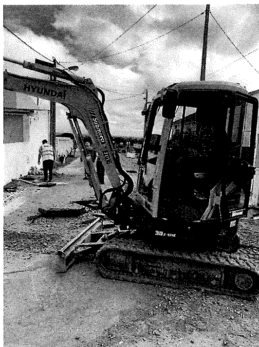
Execução de novos coletores pluviais no Bairro do Barroso e nas novas urbanizações junto ao Caminho da Vasa Borracha.
