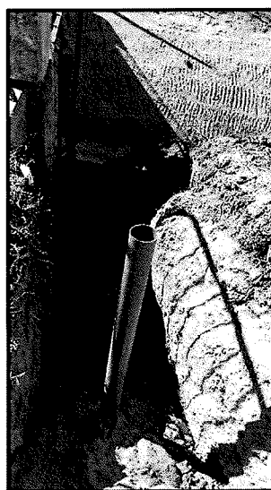
Remodelação da Rede de Abastecimento de Água
