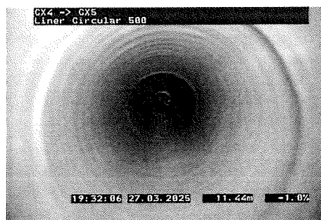
Pormenor de coletor após reparação.
