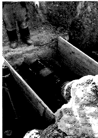
Reparação de rutura em adutora
