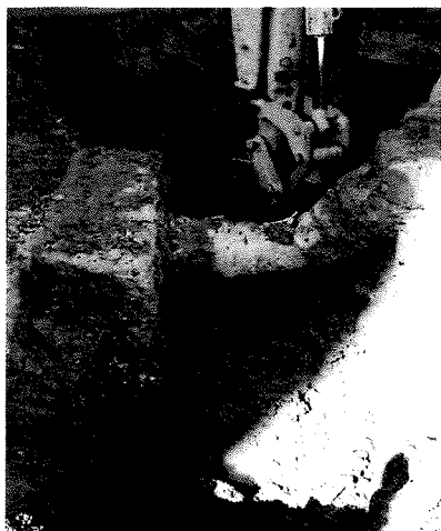
Abertura de vala para identificação de avaria numa adutora
