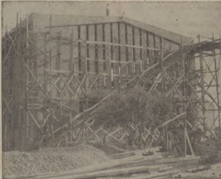
Vista parcial da Igreja de Baixa da Banheira, (na sua fase de construção)
