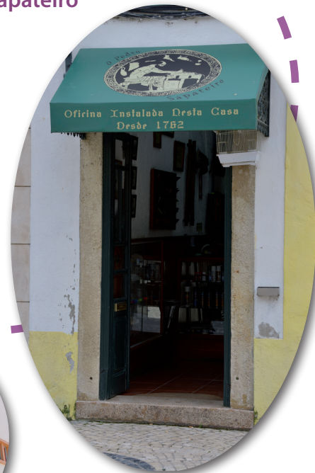
5 - Edifício com a oficina de sapateiro
