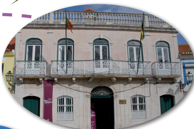
2 - Edifício do Museu Municipal
