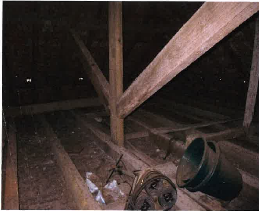
FOTO Nº2- Cobertura com estrutura em madeira e revestimento com telha cerâmica "marselha".
