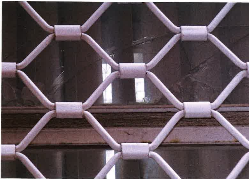
FOTO Nº8- Idem, no alçado lateral direito com indícios de esmagamento do pano envidraçado
