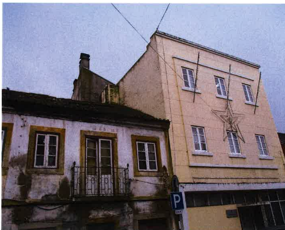
FOTO Nº1- Alçado principal e alçado lateral esquerdo
